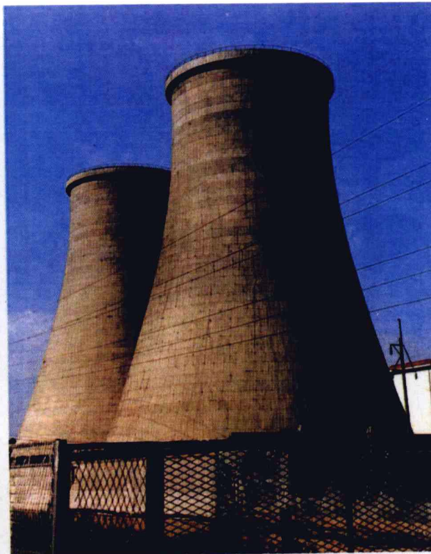
热电厂凉水塔
