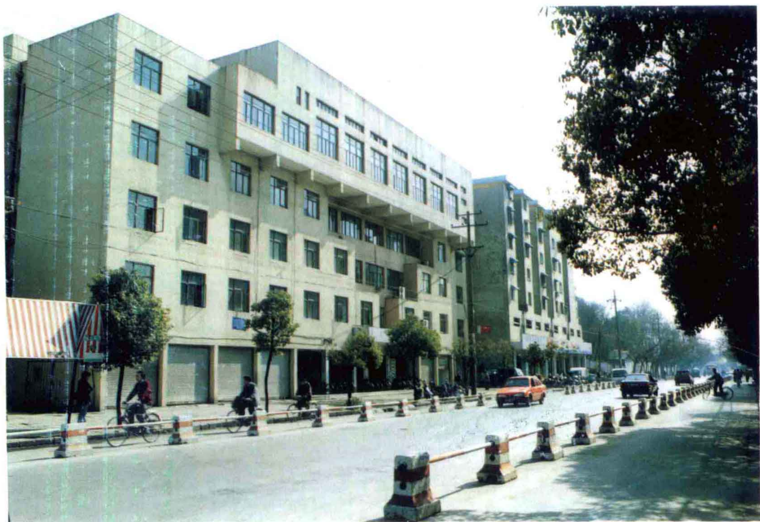
大观区区委综合办公大楼
