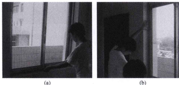
图 1-9 窗洞宽度、高度尺寸的丈量和记录
