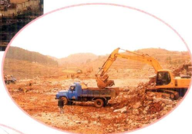
正在整地施工中的同康药业。
