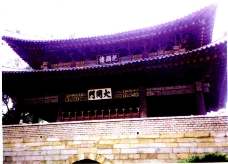
大同江畔雄伟的大同门城楼曾是平壤标志性建筑。
