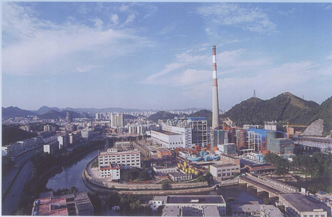
1995年11月4日,贵阳发电厂改建工程( 1 \times 20 万千瓦)建成投产
