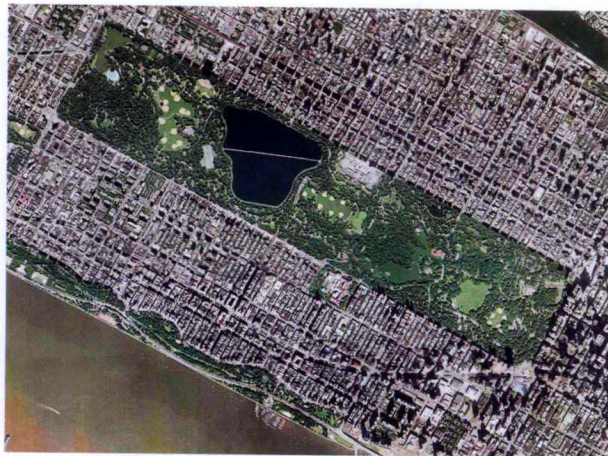
图1-2-2 位于密集建筑环绕的城市社区中的美国纽约中央公园
