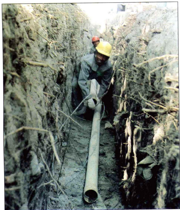
图文 挖掘管道，敷设电缆
