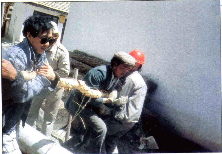
图文 市内电话外线改造施工
