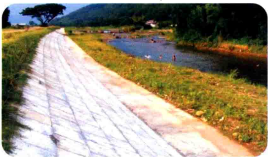
东石河坝头段堤围除险加固工程
