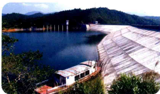
黄田水库防洪除险工程
