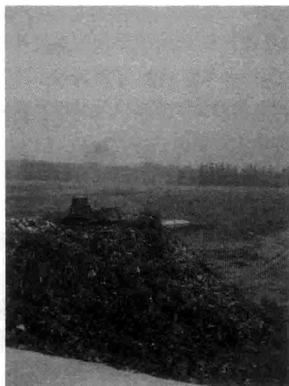
图 1-4 垃圾填埋作业照片
