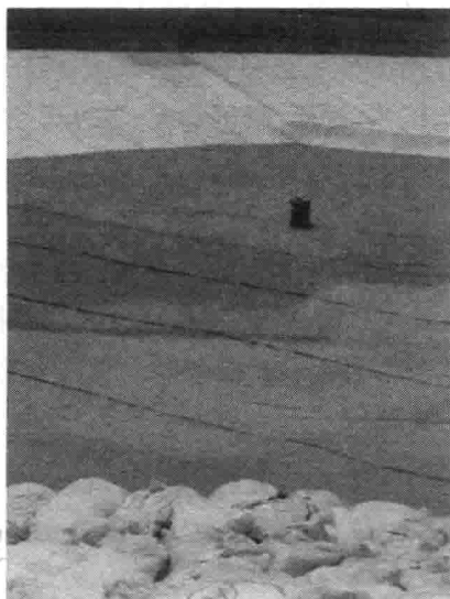
图 1-3 填埋坑施工照片
