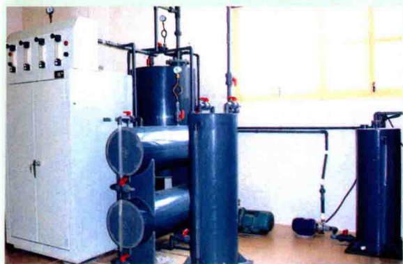
宁中镇招商引资项目——聚源科技有限公司车间一角。
