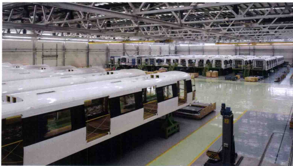
南车株机公司地铁车辆组装机房。
