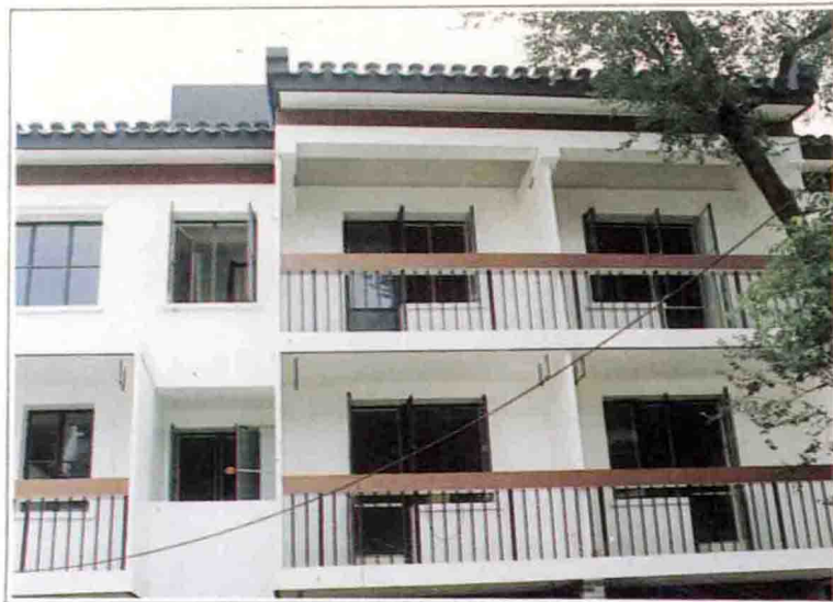
菊儿胡同危旧房改造一期工程
