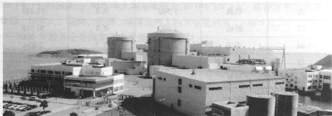
图1-2 浙江秦山三期核电站
