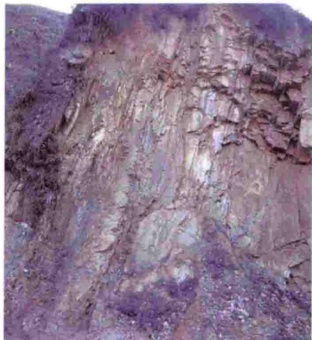
图 1-7 风化剥落
