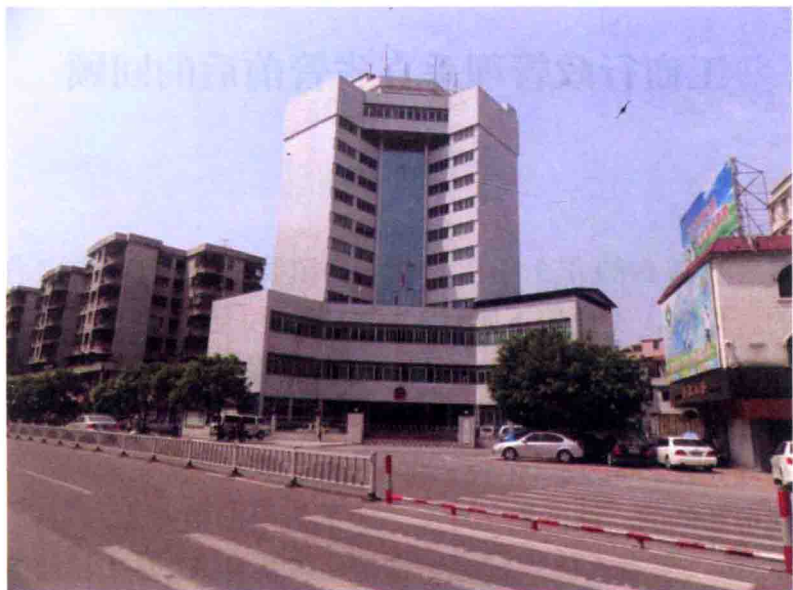
图为 1997 年 12 月 18 日落成的四会市工商行政管理局办公大楼
