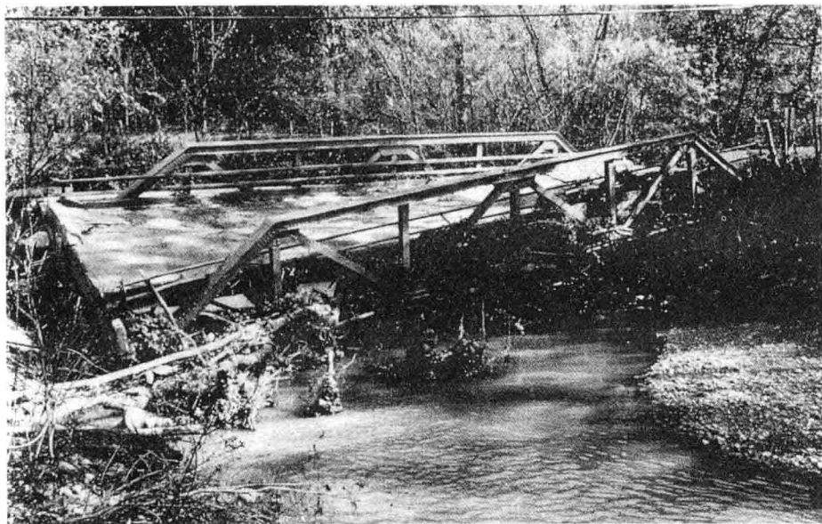
绪言图2 怀尔德伍德一座被洪水冲垮的桥梁。
