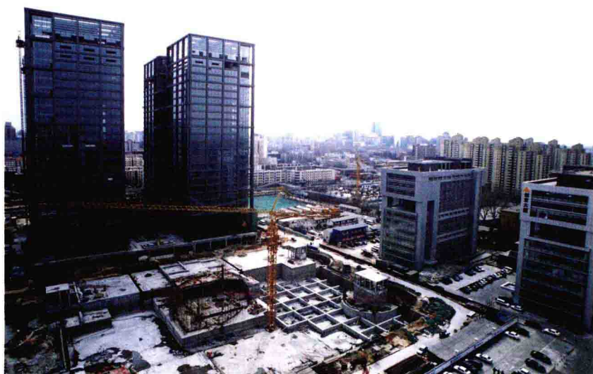
建设中的北京清华科技园
