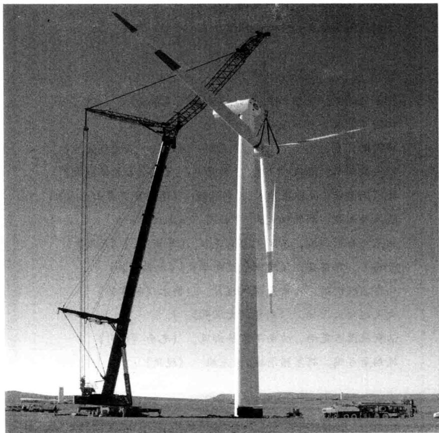
建设中的风力发电机组
