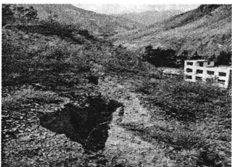
(h) 滑坡后缘拉裂缝二
