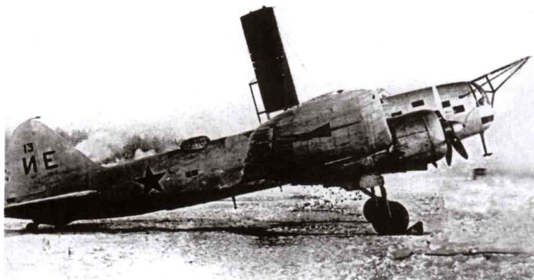
机尾编号为“13”的 DB-3 试验机携带一个窄翼弦试验段，垂尾上的字母“ИЕ”表明该试验机由 TsAGI 负责，注意机头位置的空速杆。
