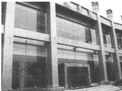
图 1-2 某科研大楼入口处
