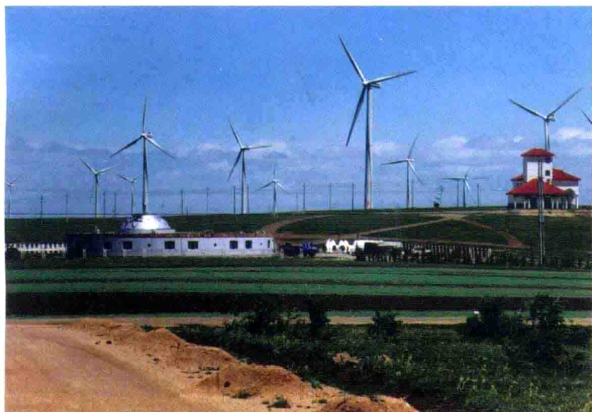
16. 内蒙古最大的风力发电场——辉腾锡勒风力发电场。
