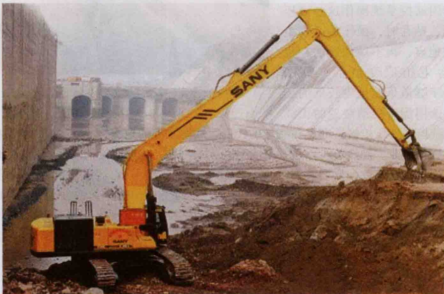
图 1.4 向家坝水电站施工现场加长臂挖掘机的应用
