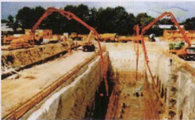
图 1.2 多台混凝土泵车在地基施工中的应用
