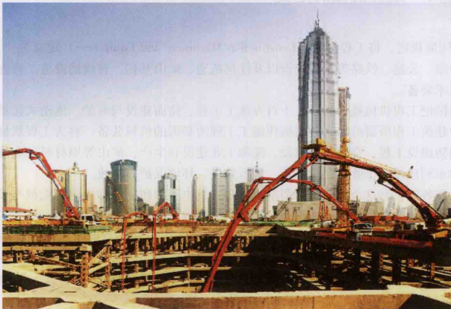
图 1.1 多台混凝土泵车在高层建筑工程中的应用
