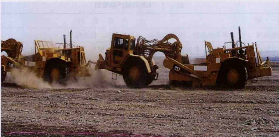
图 1.5 吐鲁番机场土方施工中铲机的应用
