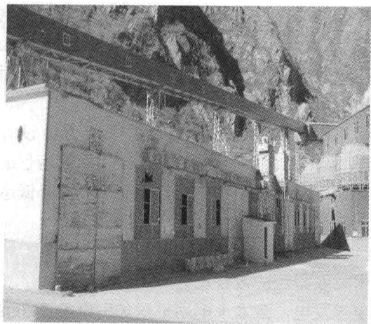
图3 藏木水电站混凝土生产系统粉煤灰拆包车间
