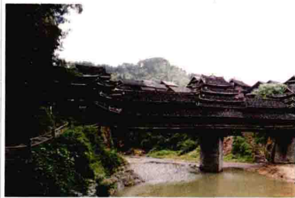
廣西三江 程陽風雨橋
