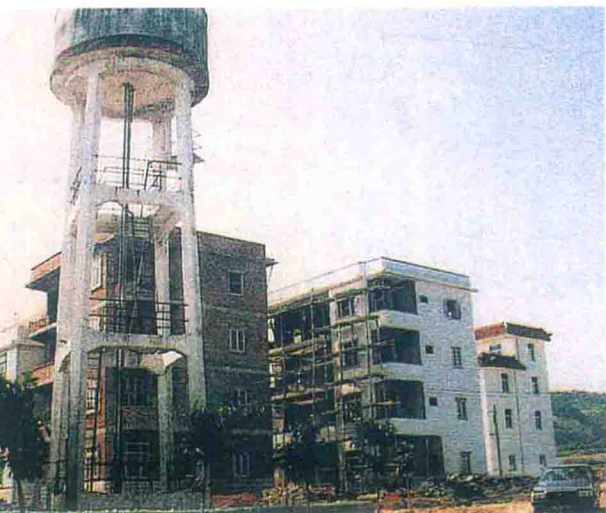
下林住宅小区
