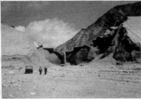
图 0-6 1993 年青海沟后水坝溃口
