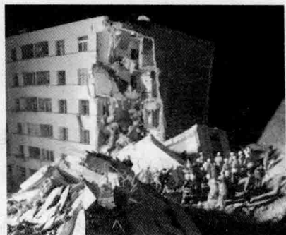
图 0-5 兰州滑坡事故导致楼房被毁
