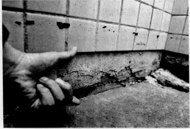
图 0-3 某隧道施工降低地下水导致的地面沉降
