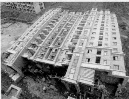
图 0-4 上海 13 层楼房整体倾倒事故
