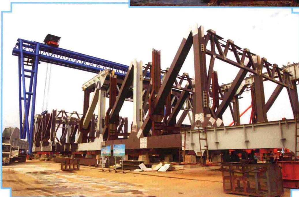
整节段钢梁拼装现场
