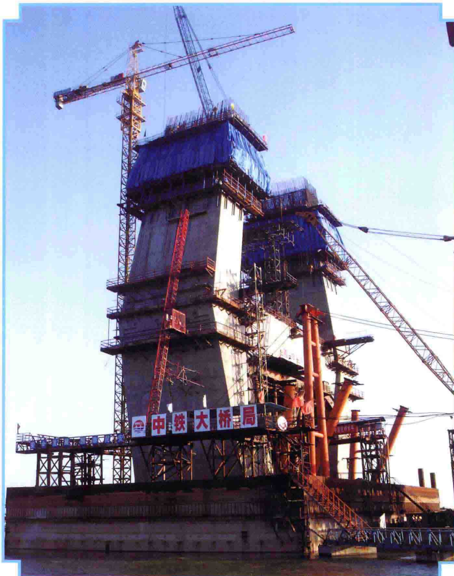
主塔施工穿上保暖衣
