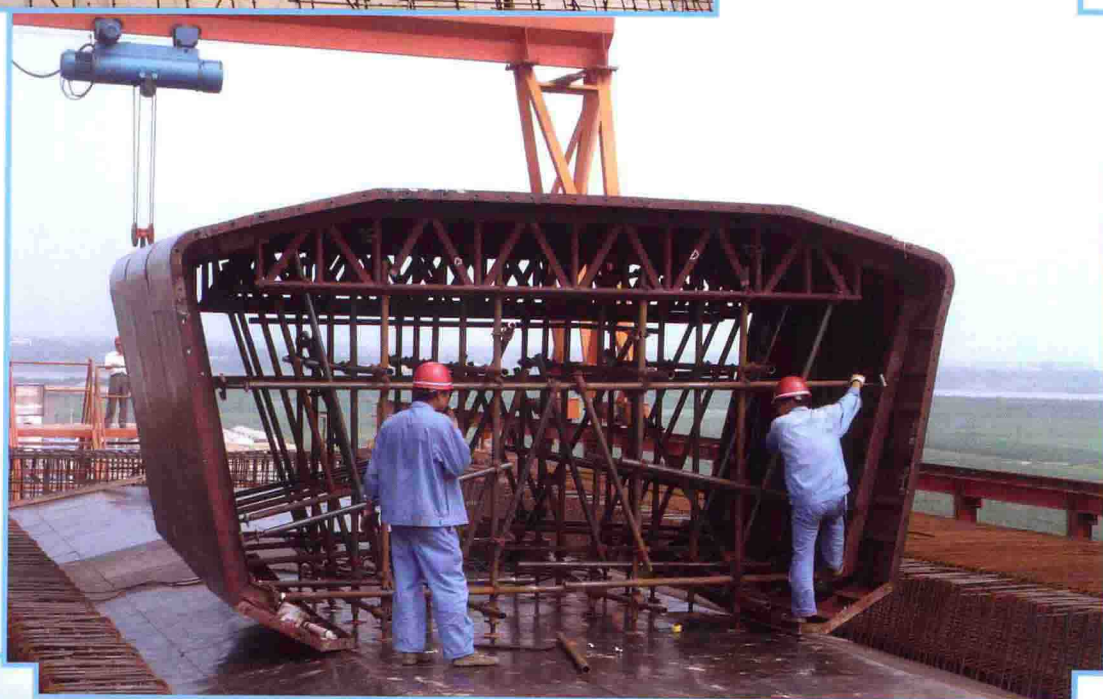
检查模板制造精度
