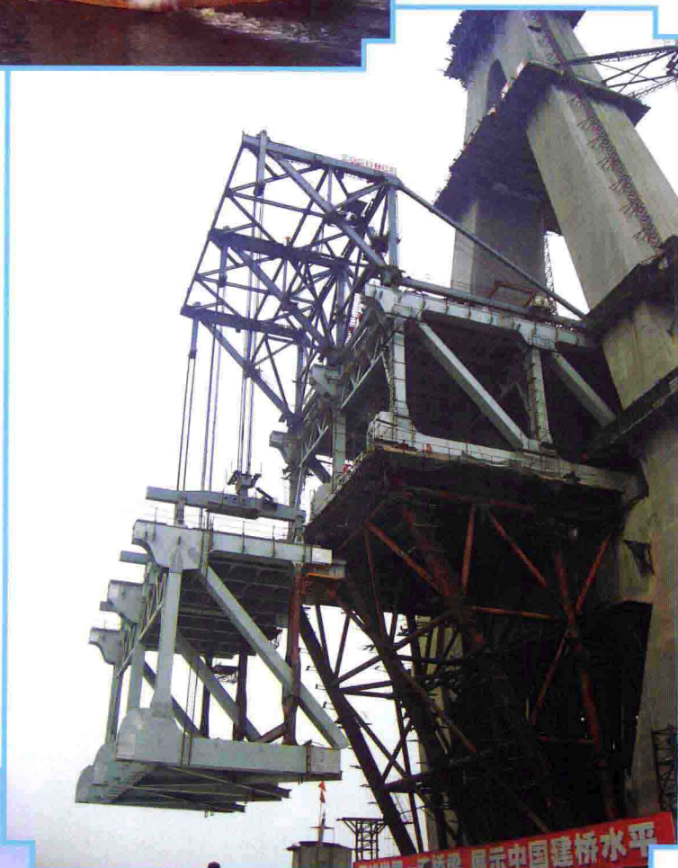
整桁段钢梁运输
