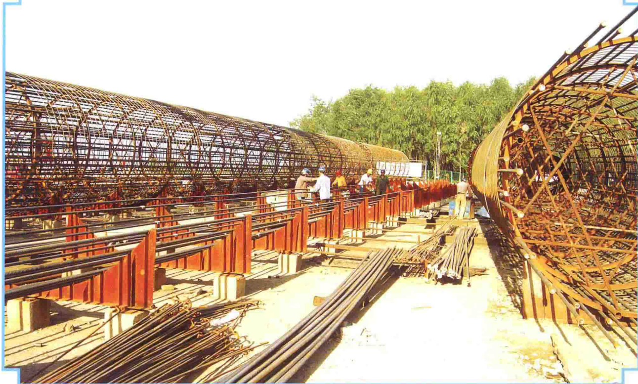
钢筋笼制造胎模化
