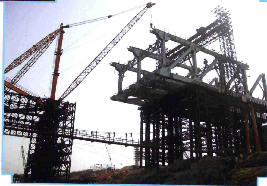
利用120 t桅杆吊机架设钢梁
