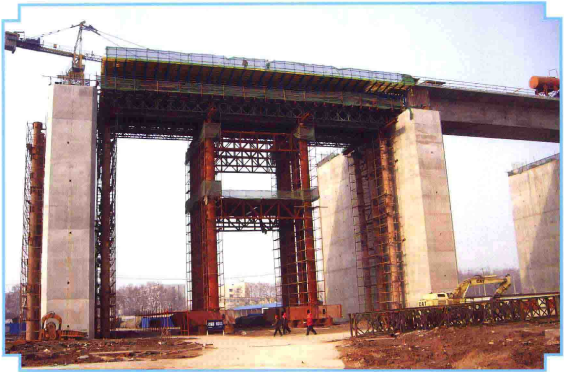
支架法施工铁路箱梁
