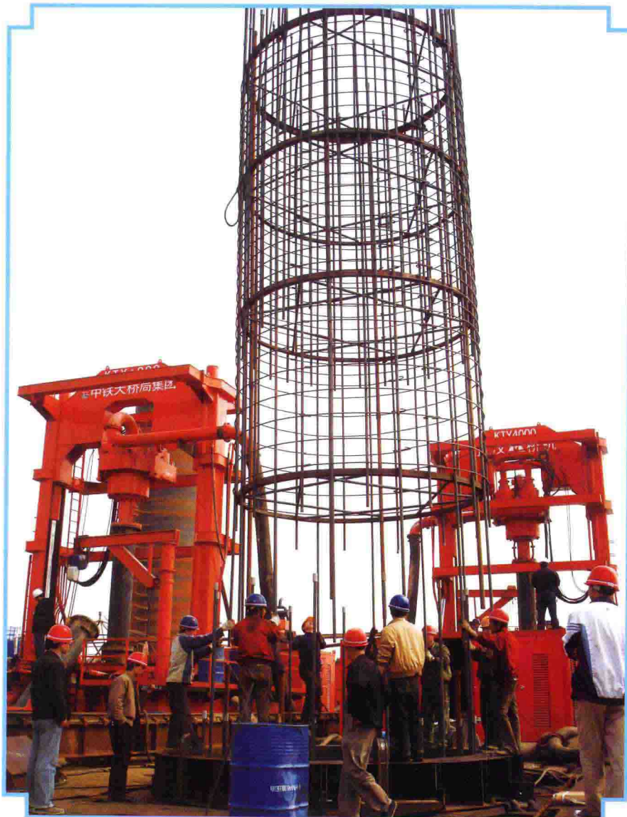
安装3.4 m大孔径钻孔桩钢筋笼
