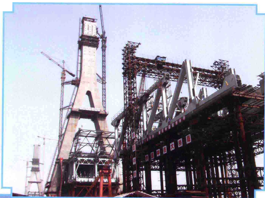
桁段架设与钢梁散拼同步施工
