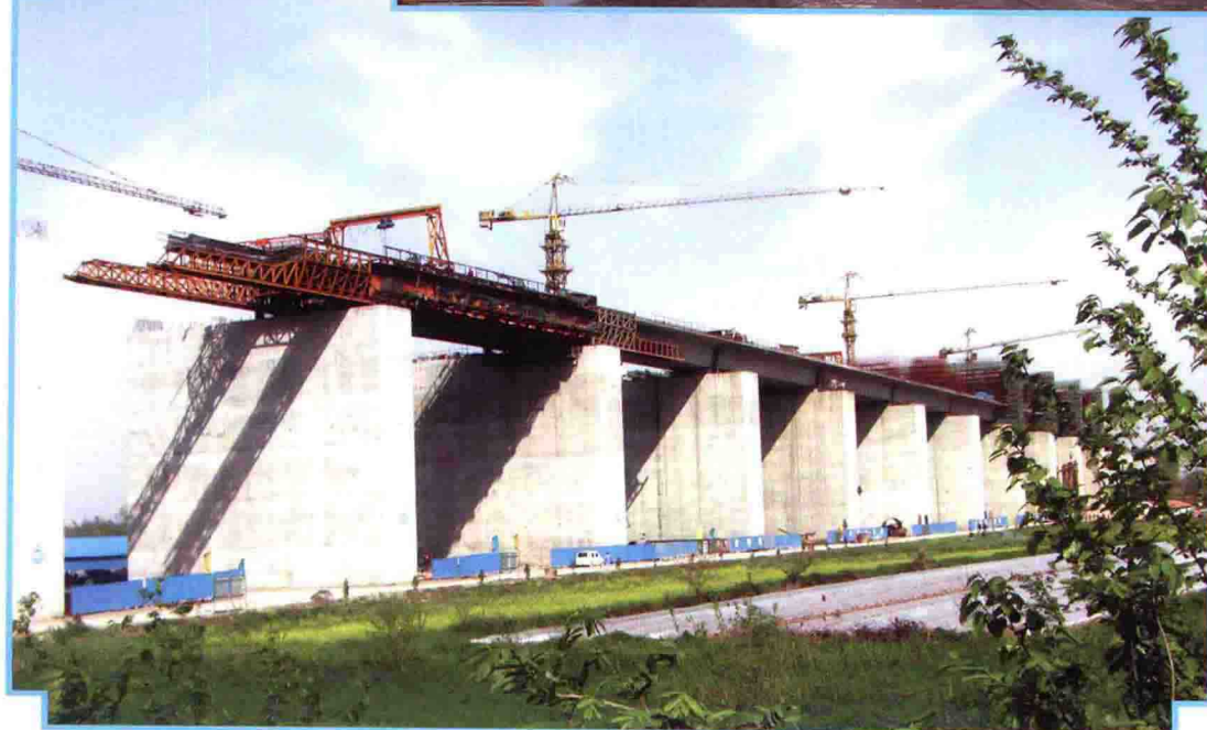
移动模架施工40 m铁路箱梁
