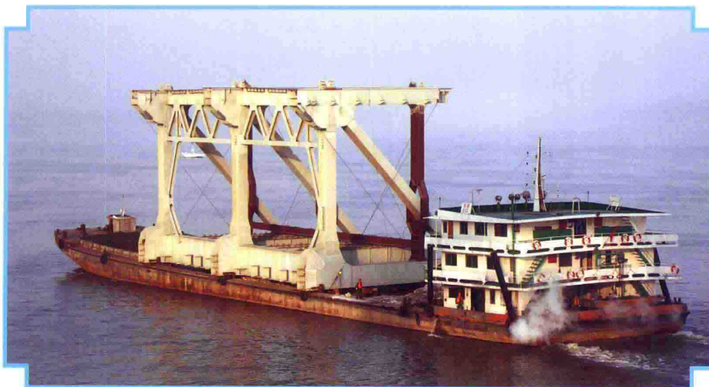
整桁段钢梁运输
