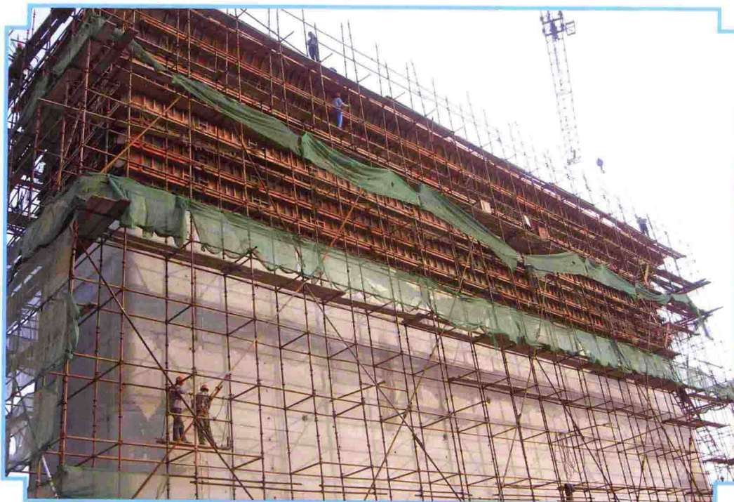
桥墩墩身施工
