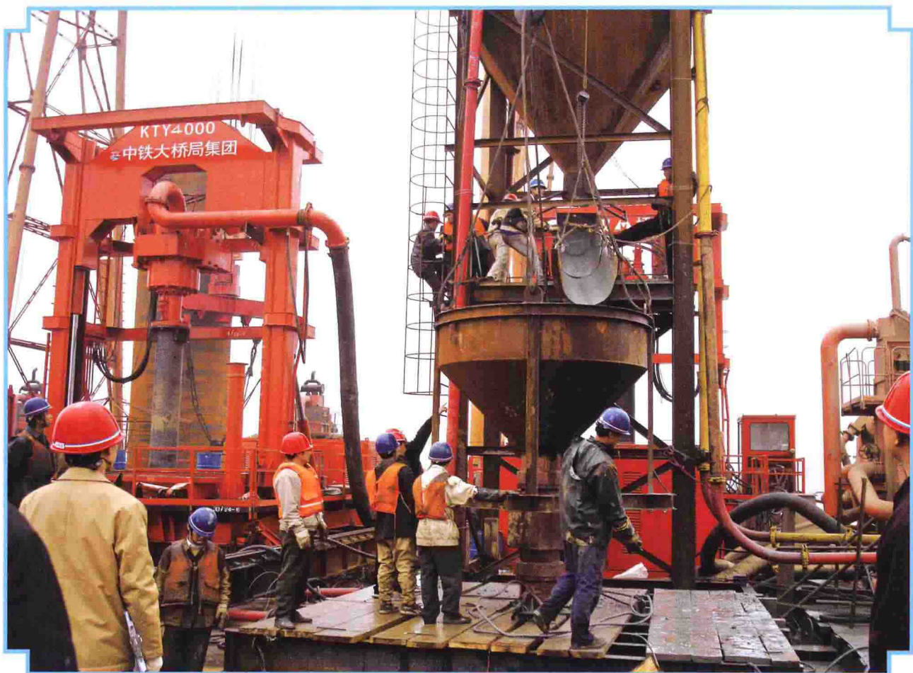
灌注水上钻孔桩混凝土
