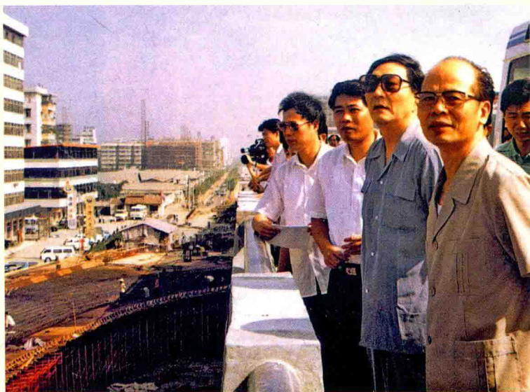
1992年9月23日，国务院副总理朱镕基（右二）在省委书记谢非陪同下视察江湾立交桥工地。
