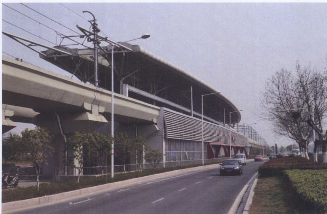
鱼腹式车站实景图——二号线学则路站
