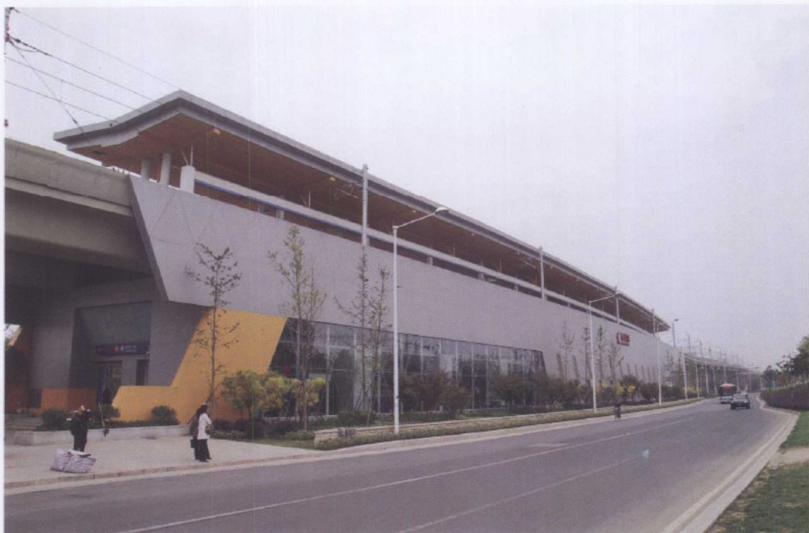
鱼腹式车站实景图——二号线仙鹤门站
