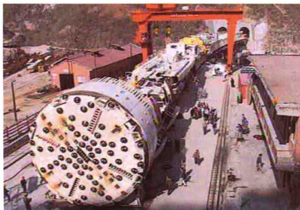
正在组装的TBM
