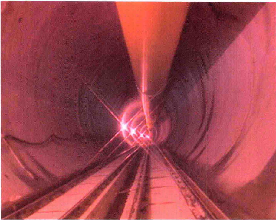
开敞式 TBM 开挖的硬岩隧道
