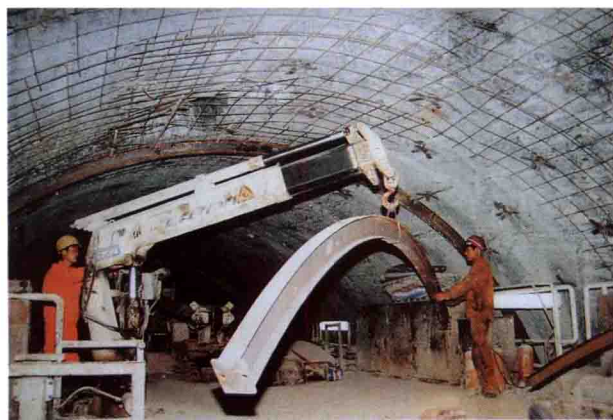
上部吊机吊装钢拱架
