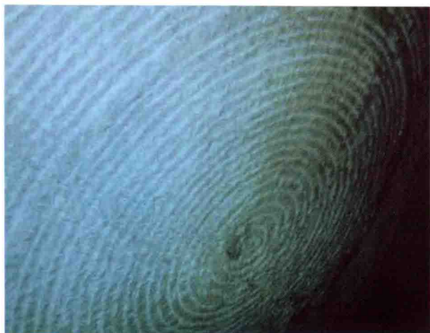
秦岭隧道 TBM 切削岩面
