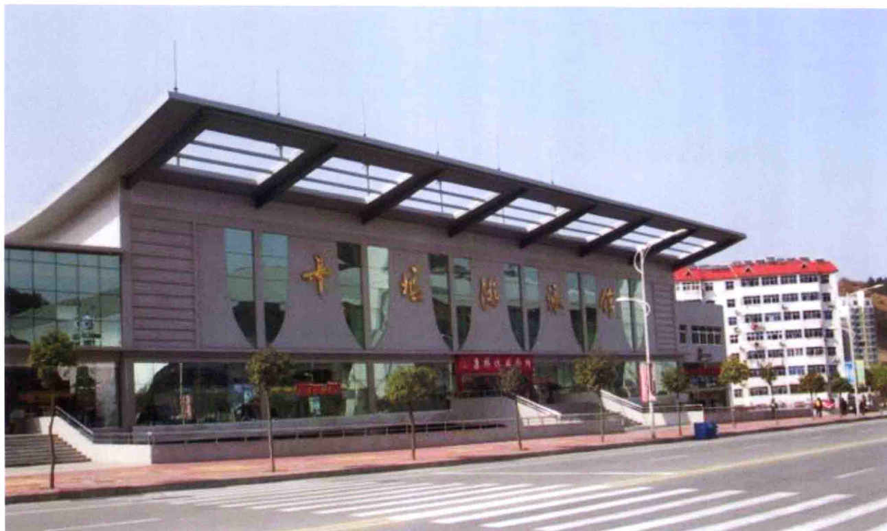
新竣工的十堰市游泳馆外景
