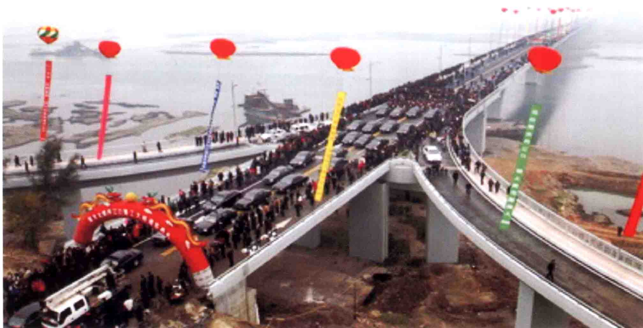
2006年12月6日，南水北调丹江口施工大桥正式建成通车
