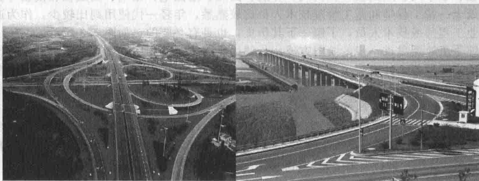
图 1.1 道路与桥梁工程
