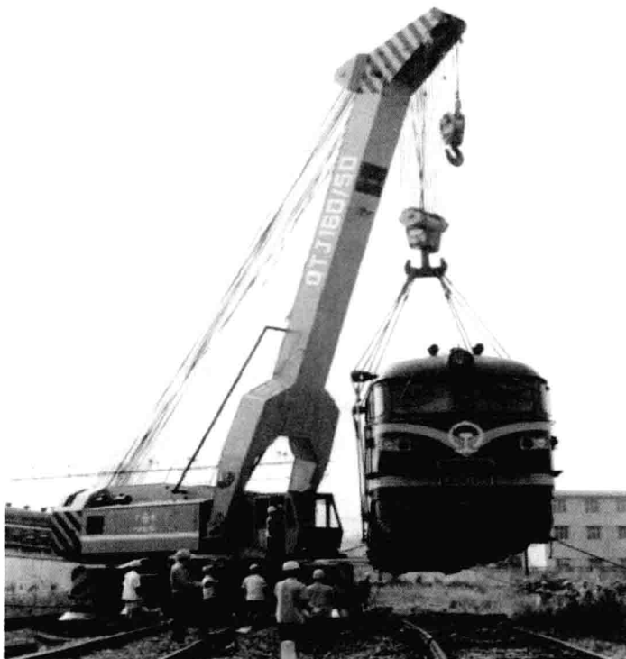
图 1-3 N1602 型 160 t 内燃液压定长臂式铁路救援起重机
