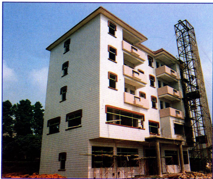
建设中的镇派出所办公大楼
