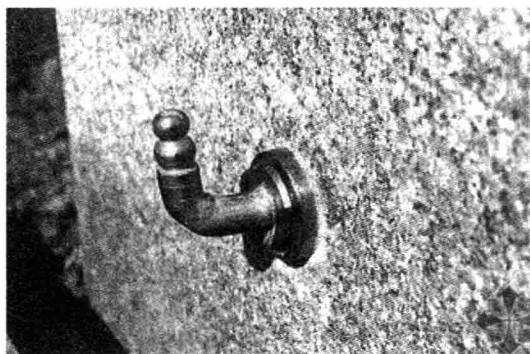
图 1-4 施工现场的沉降观测点
