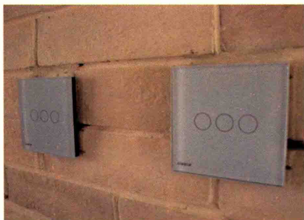
图 1-1-19 触感开关, 以感应方式开关灯
