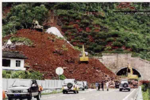
图2-4 运营过程中隧道边、仰坡坍塌
