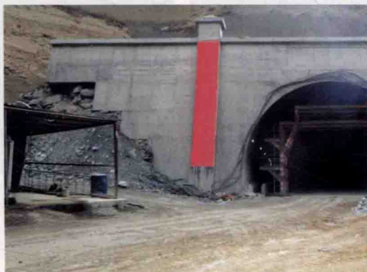
图2-5 洞门端墙基础悬空
