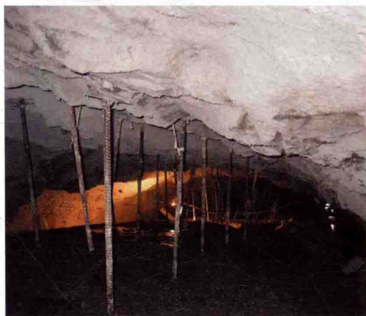
图3-1 拱顶超挖严重
