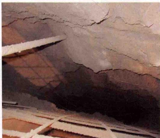
图3-1 拱顶超挖严重
