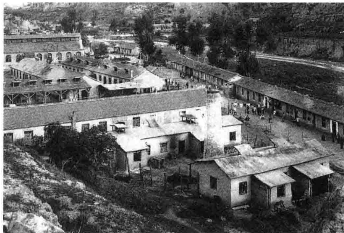
山西省武乡县柳沟村八路军总部军工部柳沟铁厂旧址
