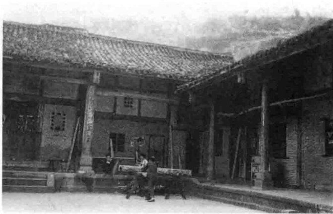
1933年初，徐向前领导的红四方面军在川北通江县苟家湾建立的通江兵工厂旧址
