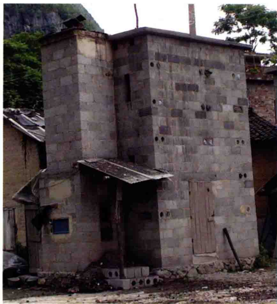
(c) 一种平顶热风循环普通烤房
