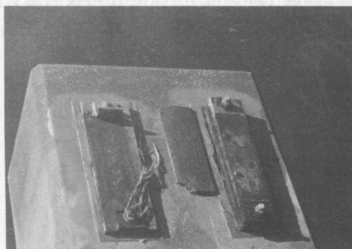
图 1.4 飓风 Katrina(2005)所造成的 I-10 桥梁支座处破坏
