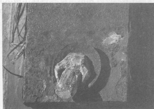
图 1.4 飓风 Katrina(2005)所造成的 I-10 桥梁支座处破坏
