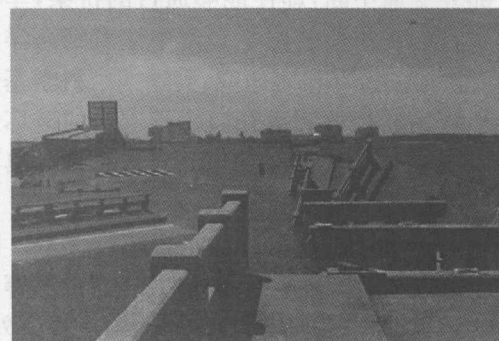
图 1.5 飓风 Katrina(2005)所造成的 I-10 和 US-90 号桥梁破坏
