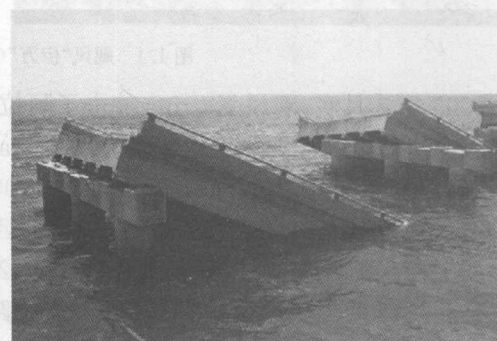
图 1.4 飓风 Katrina(2005)所造成的 I-10 桥梁支座处破坏
