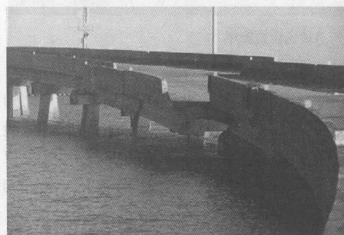
图 1.4 飓风 Katrina(2005)所造成的 I-10 桥梁支座处破坏
