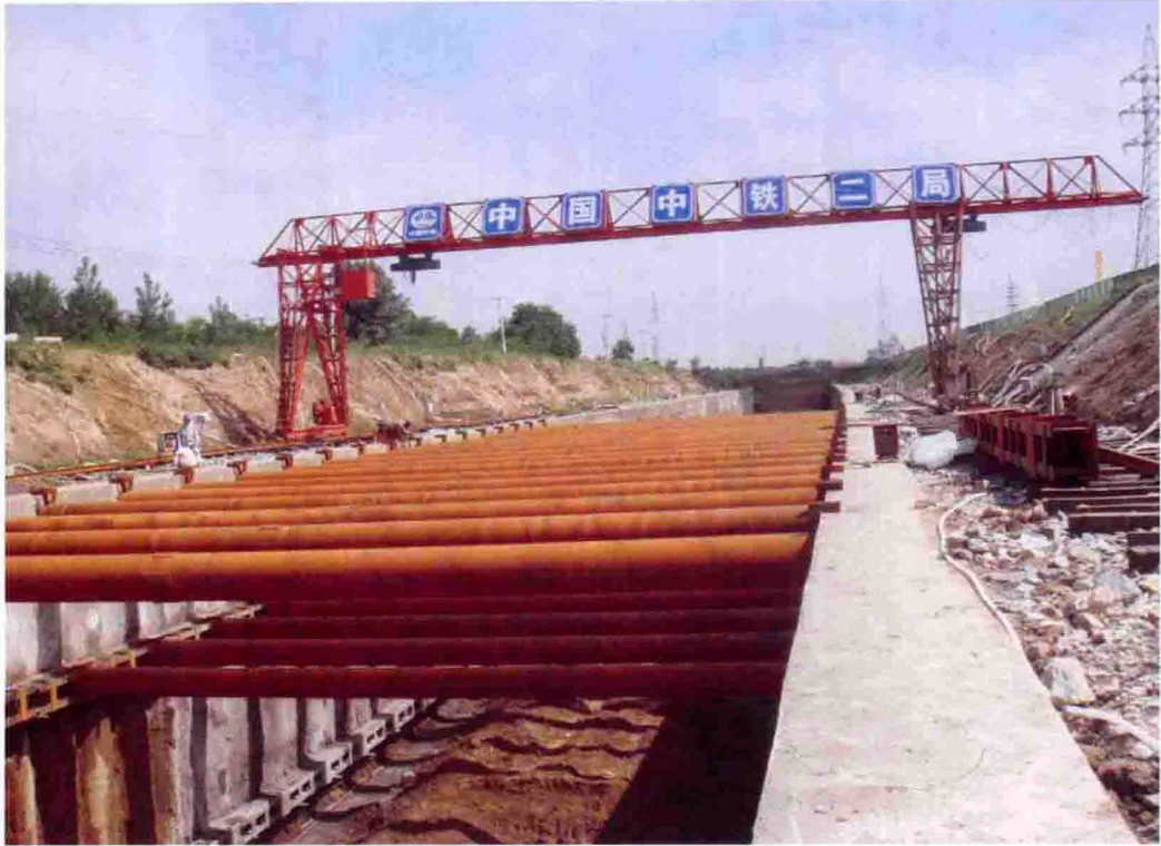
鞍山隧道钢支撑
