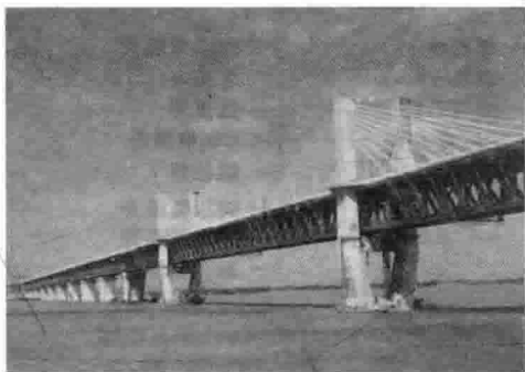
图 1-3 芜湖长江大桥
