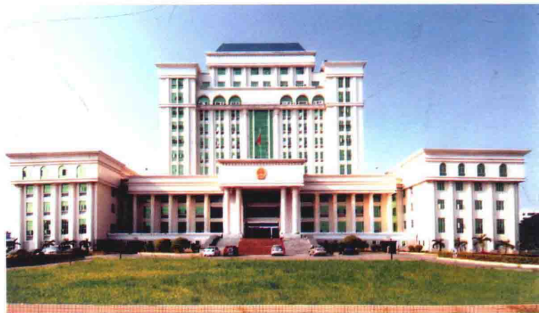
2002 年 1 月建成的潮阳市人民法院大楼
