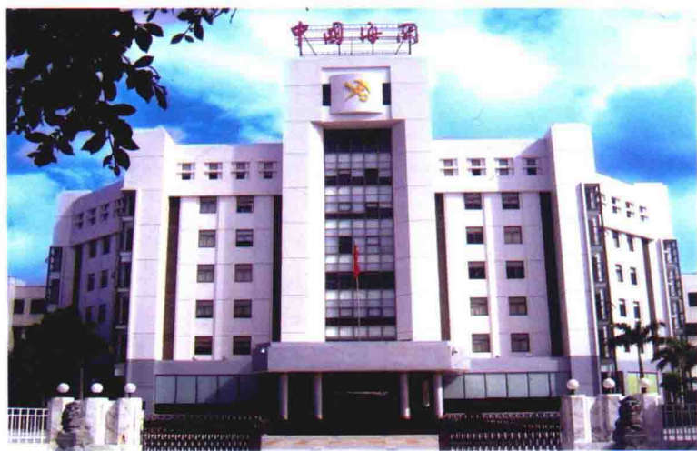
1993 年建成的潮阳海关大楼
