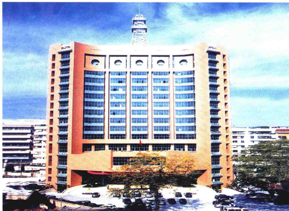
2001年10月建成的潮阳市公安局110指挥中心大楼
