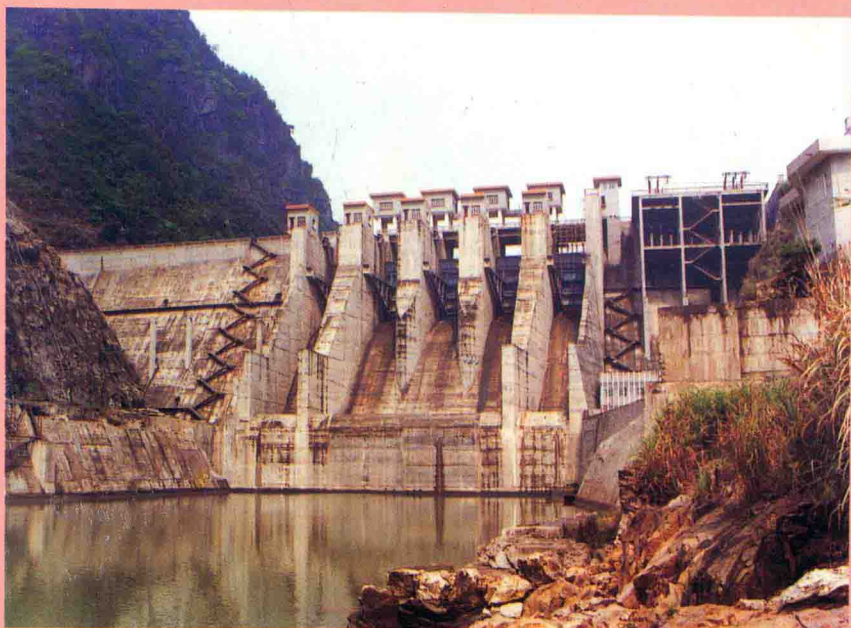
建设银行梅州市分行 拨款和贷款支持建成的装 机6万千瓦的蕉岭长潭水 电站。
