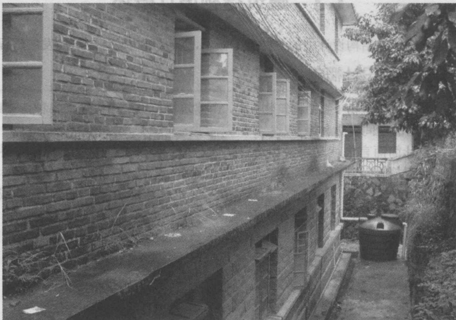
图 1-2 砖混结构
