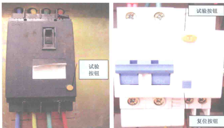
图 1-6 常见漏电断路器式样
