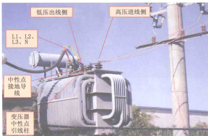
图 1-1 中性点直接接地的 220V/380V 三相四线制变压器示意图
