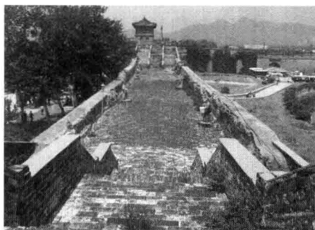
图 2.2 两侧包砖、内夯土(山海关关城东墙)
