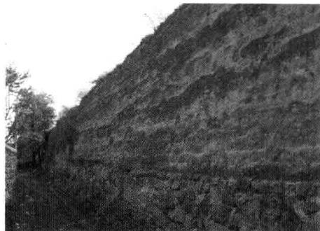
图 2.3 外侧砌砖、内侧夯土（东罗城）
