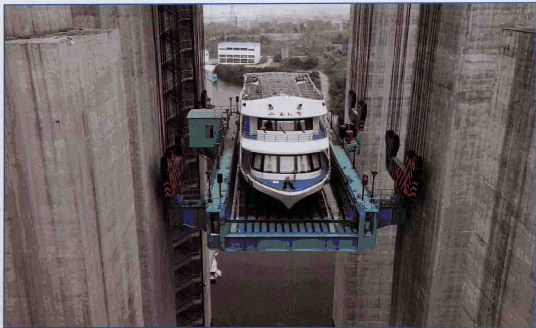
■ 2012年11月，南水北调中线水源丹江口大坝加高工程升船机安装调试完成，图为过船试验。 (班静东 摄)
