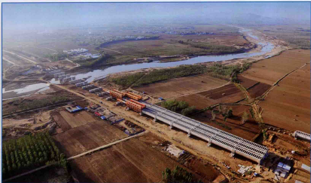
■ 2012年12月，南水北调中线一期工程湍河渡槽建设现场。
