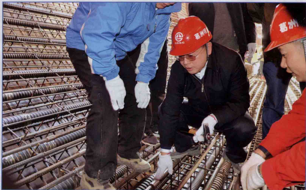
■ 2012年11月，国务院南水北调办副主任蒋旭光率组对南水北调中线一期工程河南省境内工程进行质量专项检查。 (国务院南水北调办综合司 供稿)
