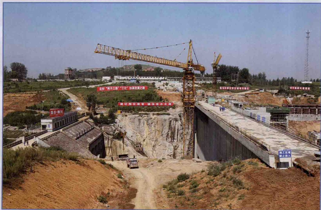
■ 2012年9月，正在建设中的南水北调中线一期工程陶岔渠首枢纽工程。 (余培松 摄)
