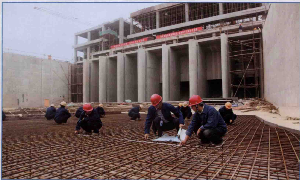
■ 2012年9月，南水北调东线一期工程睢宁二站工程建设现场。
