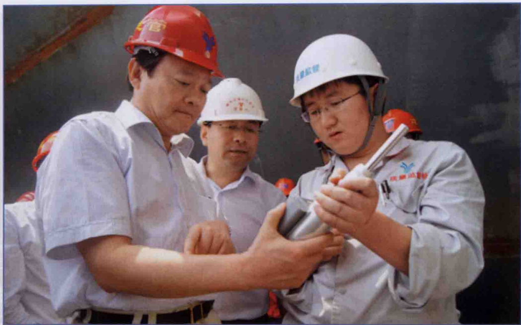
■ 2012年5月，国务院南水北调办副主任于幼军检查南水北调中线一期工程兴隆枢纽泄水闸混凝土强度回弹检测值。 (国务院南水北调办综合司 供稿)
