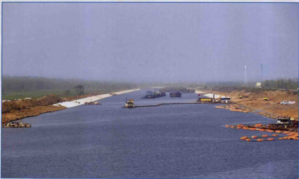
■ 2012年11月，施工队伍正在对通航条件下的南水北调东线一期工程梁济运河进行清淤。
