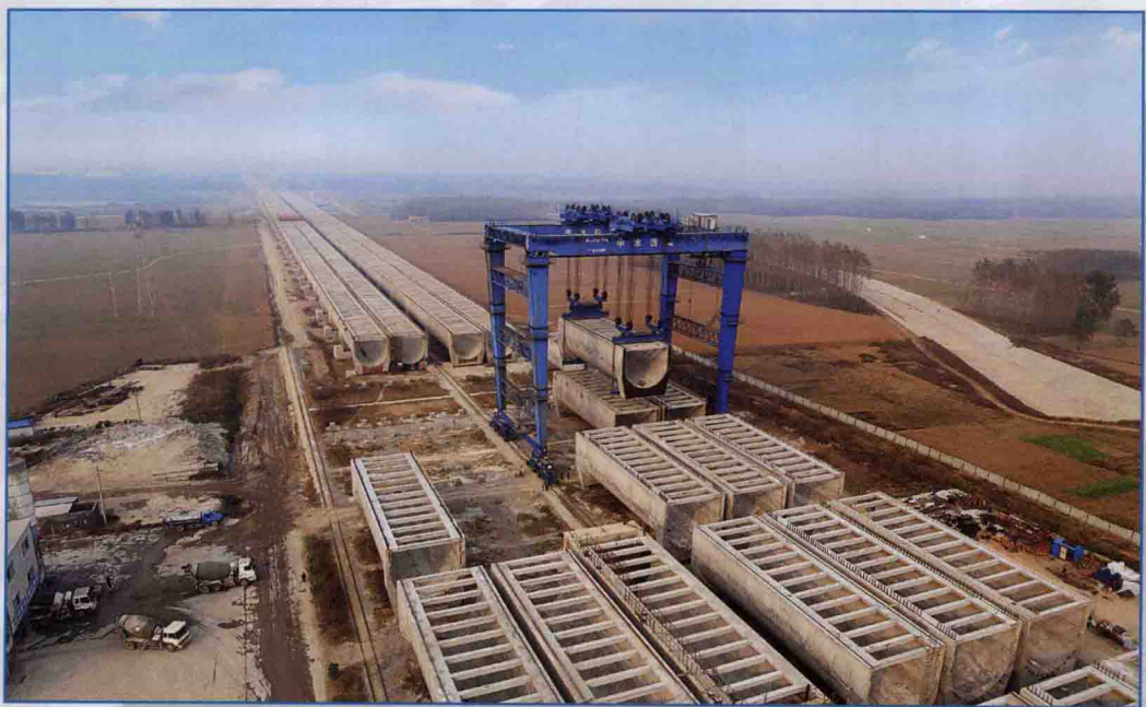
■ 2012年12月，南水北调中线一期工程沙河梁式渡槽施工现场。
